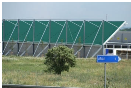
Situace v červnu 2008. Protihlukové stěny u Tesca v Úžicích po dokončení.
